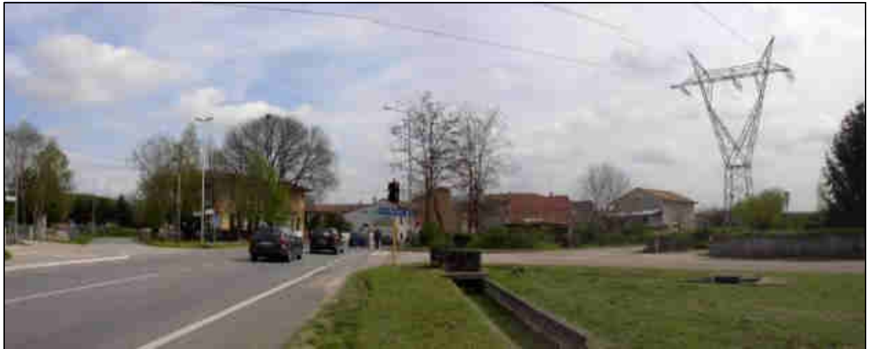
Foto 1: Abitato di Basagliapenta: in un contesto di edifici bassi, l'interferenza del viadotto sarà elevata.
